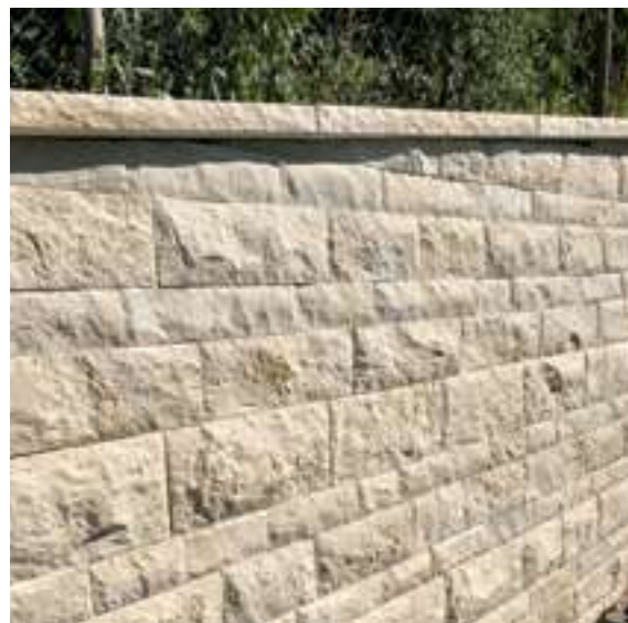
Schichtmauerwerk mit Abdeckplatten
