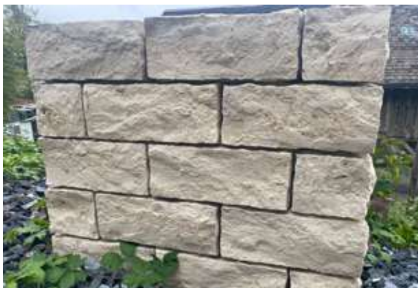
Schichtmauerwerk mit Kanten zurück geschlagen
