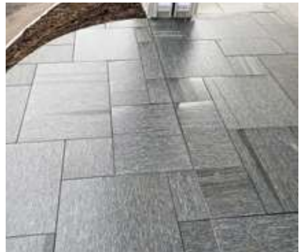
Bodenplatte Maggia römischer Verband
