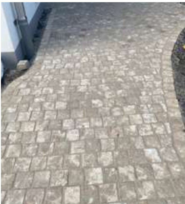
Pflastersteine Dolomit, Oberfläche gestockt
