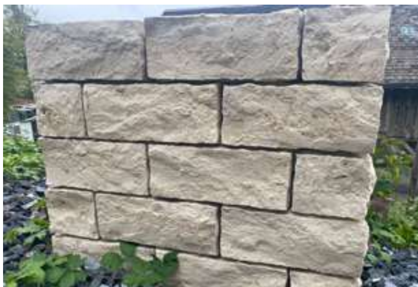
Schichtmauerwerk mit Kanten zurück geschlagen
