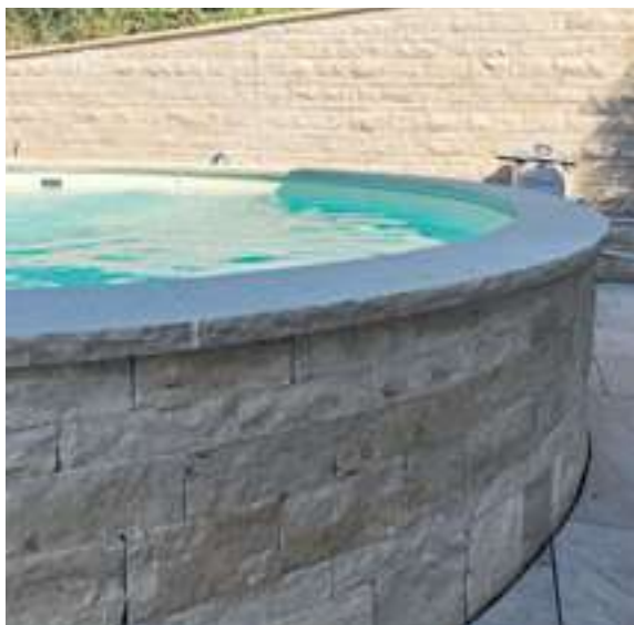
Poolumrandung mit Schichtmauerwerk
