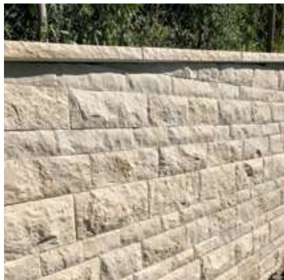
Schichtmauerwerk mit Abdeckplatten
