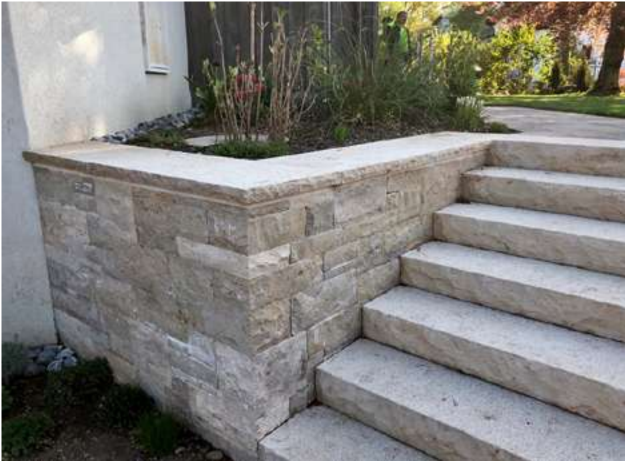
Systemmauerwerk – Gartenstufen gestockt
