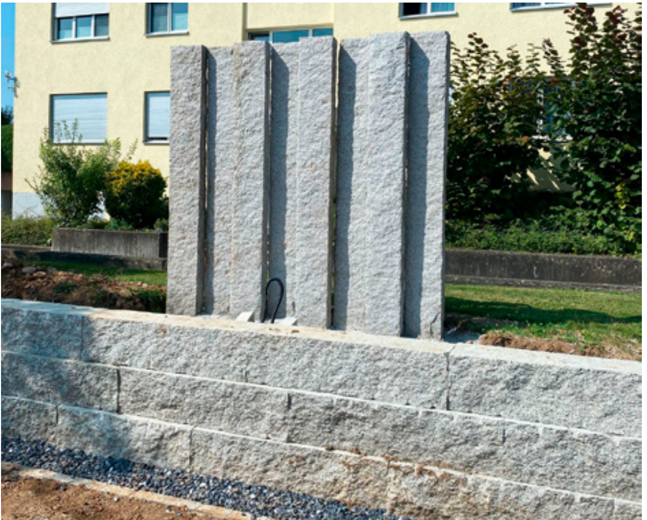
Quadersteine Polen Granit gesägt und Palisaden Granit hellgrau
